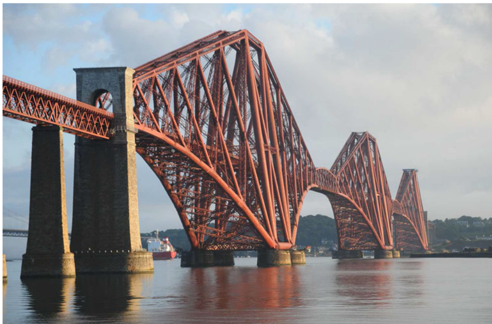
Forth Bridge über den Firth of Forth, Queensferry (Schottland). Foto: Rüdiger Lunde
