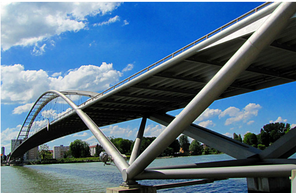
Dreiländerbrücke zwischen Weil am Rhein und Huningue. Foto: Rita Wurth
