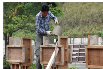
j Pouring concrete
