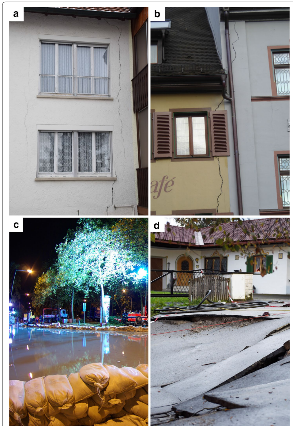
Fig. 3 Damages in Böblingen ( a ), Staufen ( b ), Wiesbaden ( c ), and Rottach-Egern ( d ). ©: a Paul Fleuchaus, b Christoph Butscher, c Michael Ehresmann, and d Thomas Plettenberg
