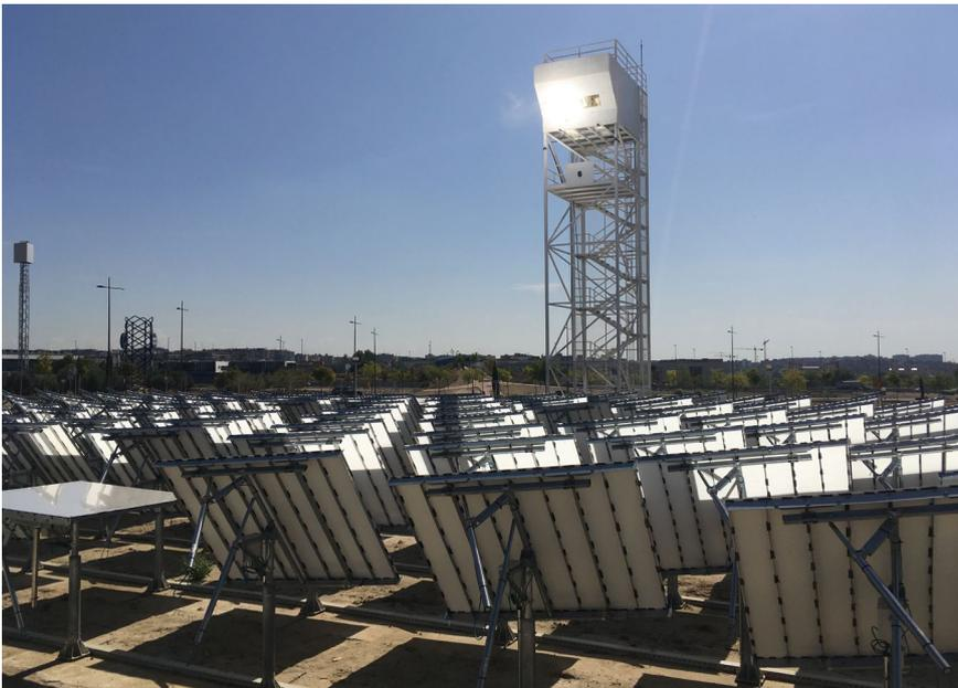
Der Solarturm vom Forschungszentrum IMDEA Energy in Móstoles, Madrid: Das Spiegelfeld konzentriert Sonnenlicht auf die Spitze des Solarturms, wo die erzeugte Solarwärme für die Herstellung von synthetischen Treibstoffen genutzt wird. (© Synheliion)
