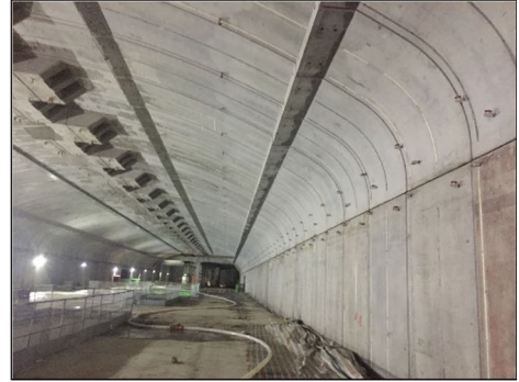
(d) Construction of floor slab
