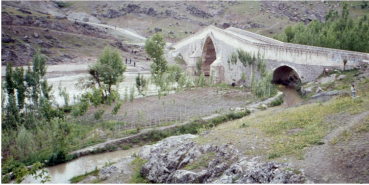
Fig. 5 Watermill supply canal through the Seljukide Haburman bridge in Çermik (photo:Ü.Öziş)
