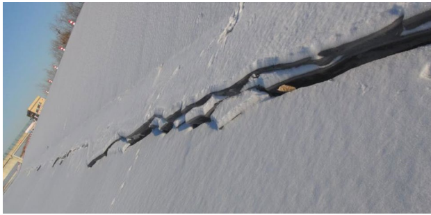
Fig. 1 Longitudinal crack
