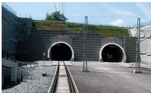
Fig. 3 The eastern portal of the Ejpovice tunnel (Plzeň.cz Zpravodajský portál 2019)
