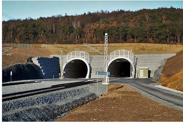
Fig. 4 The western portal of the Ejpvovice tunnel (Plzeň.cz Zpravodajský portál 2019)
