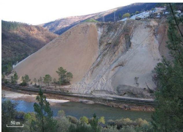
Fig. 2 Slope of the Cabeço do Pião tailings deposit
