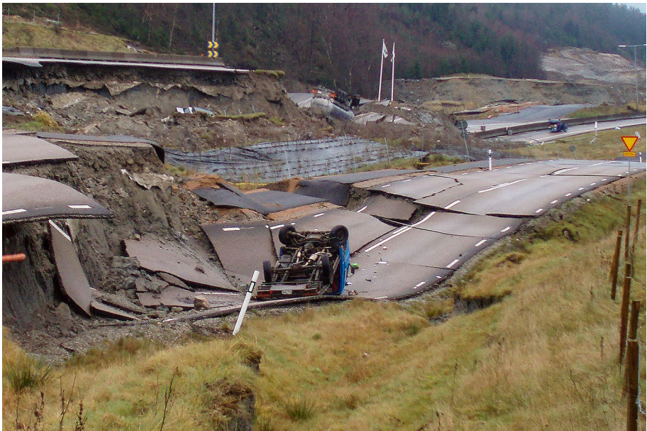
Fig. 1 Quick clay landslide in Småröd, Munkedal, Sweden, 2006 (foto SGI)
