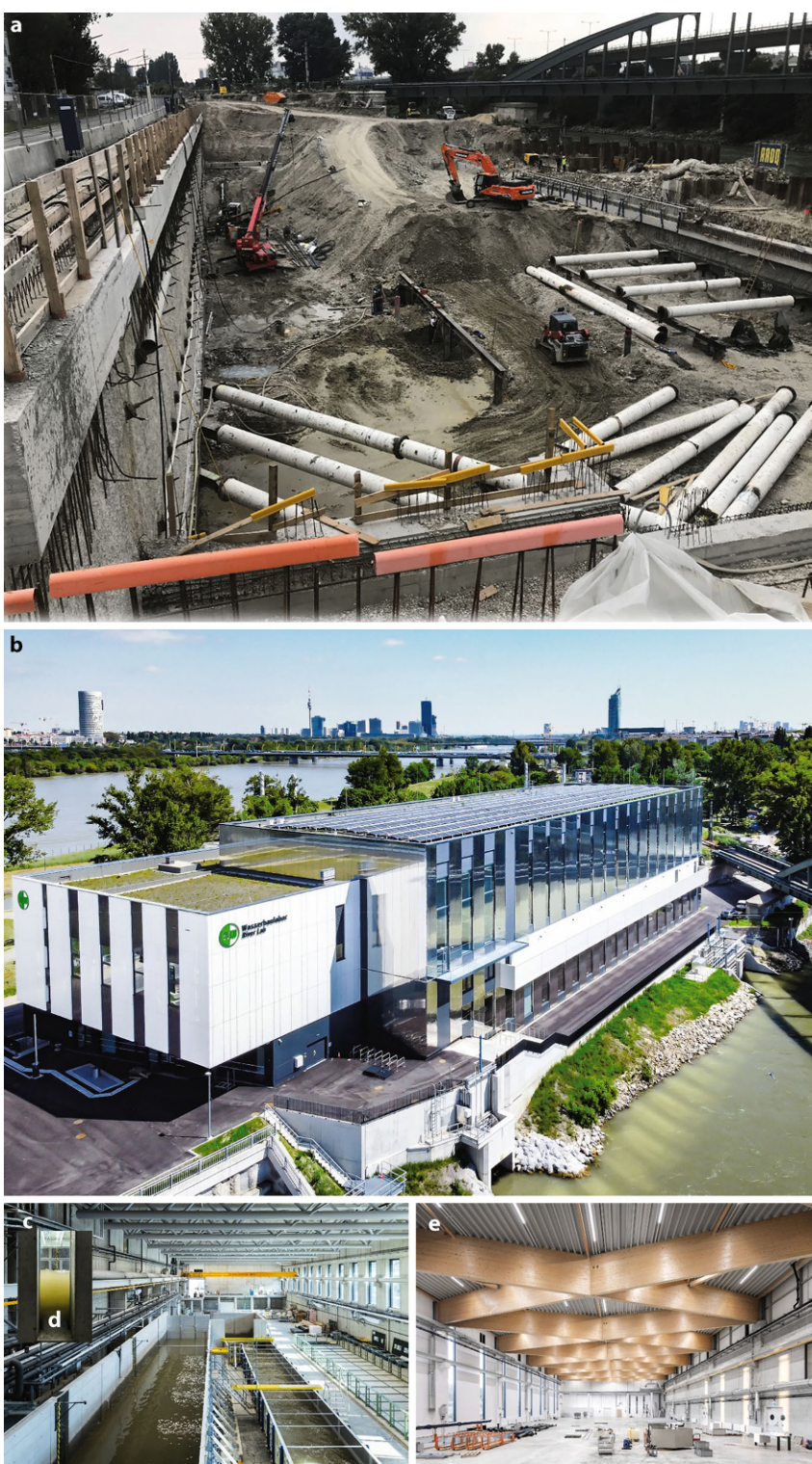
Abb. 8 Fotos vom im Bau befindlichen (a) und umgesetzten BOKU Wasserbaulabor (b), Main Channel (c), Sichtfenster (d), River Lab (e). (Fotos: Habersack, Gruber, Kuball)
