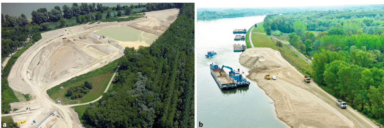
Abb. 17 Umlandabsenkung im Mündungsbereich im Bau mit Kiesentnahme, offenem Grundwasser und wieder eingebrachtem Feinsediment (a, Foto: G. Pock), Kiesverladestelle im Stauraum des Donaukraftwerks Altenwörth (b, Foto: Markus Haslinger extrem-fotos.com)
