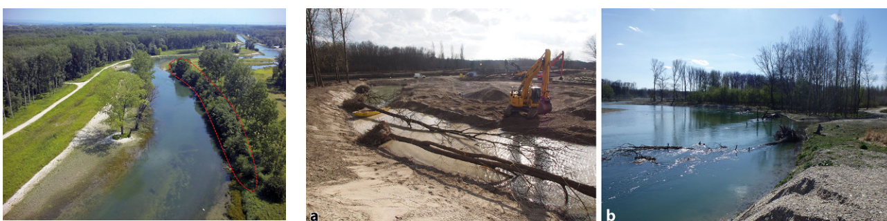
Abb. 12 Entlang der Prallufer werden „Pufferzonen“ für eine ungehinderte Ufererosion vorgesehen
