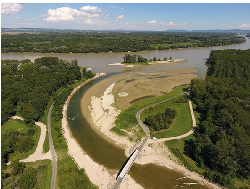
Abb. 16 Neuer Mündungsbereich der Traisen in die Donau bzw. einen Donau-Seitenarm und großflächige Umlandabsenkung mit Stillgewässern (rd. 5 ha) kurz nach Fertigstellung und bei Rückgang eines geringjährlichen Donauhochwassers (Foto: G. Pock)
