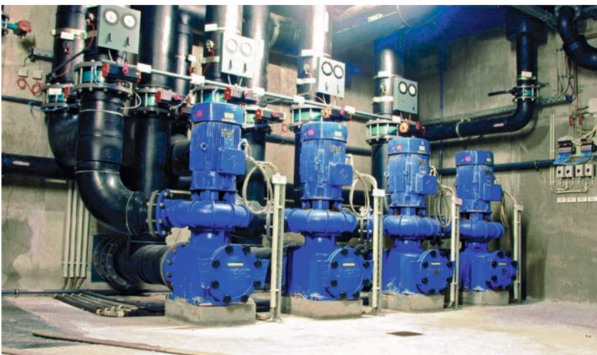
Abb. 1: Die Reduzierung der Drehzahl um 20 % kann bei Pumpenanwendungen im Idealfall die Energiekosten um bis zu 50 % senken.
