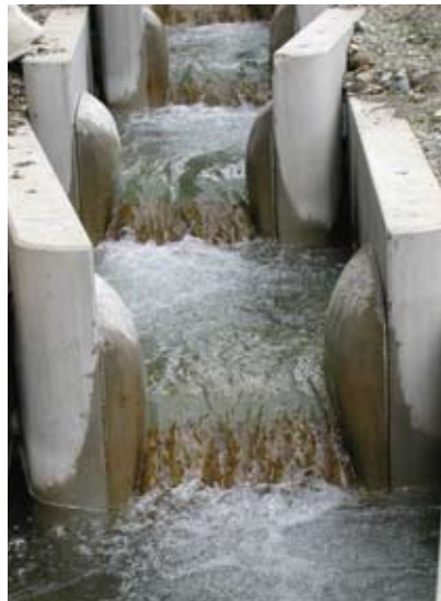
Abb. 5: Fischwanderhilfe, System Beckenpass
