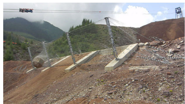
Abb. 1: Systemerstprüfung nach EAD 340059-00-0106 am ehemaligen Prüf- und Forschungszentrum Erzberg der Trumer Schutzbauten GmbH
