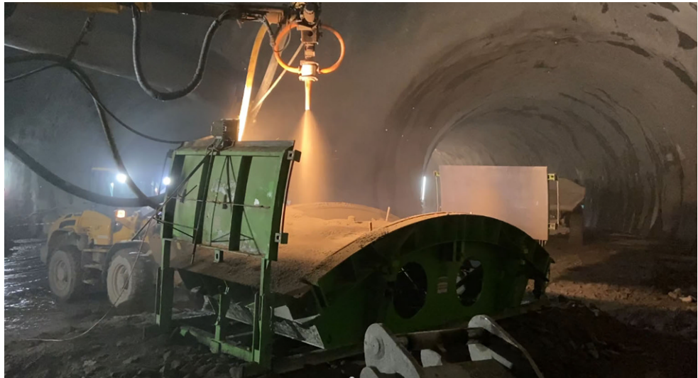
Abb. 1: Herstellung der Faserspritzbetontübbinge
