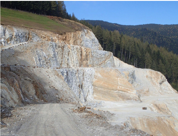
Abb. 4: Mit dem gebirgsschonenden Vorspaltverfahren hergestellte Abbauböschungen im Bereich der Etagen, Bankungsfläche und zugleich Qualitätsgrenze im Einfallen
