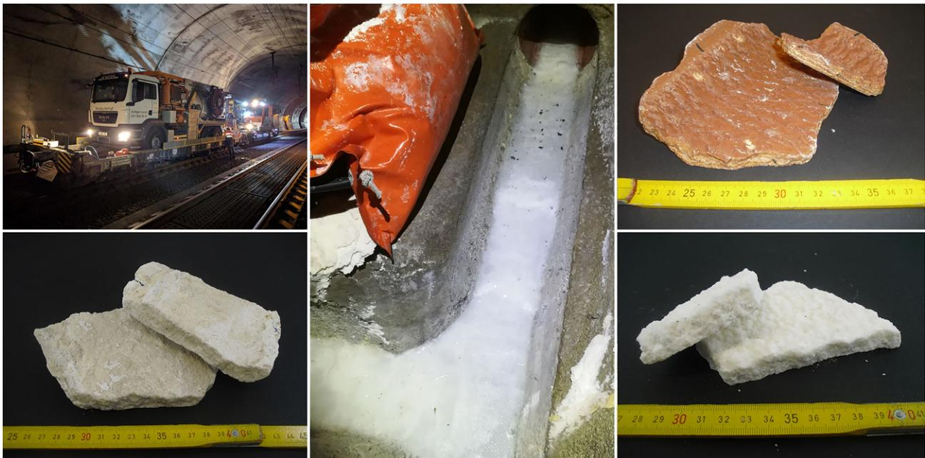
Abb. 1: Entfernung von Versinterungen in einem Eisenbahntunnel und die unterschiedliche Beschaffenheit (z. B. chemische Zusammensetzung, Färbung, Konsistenz) von Ablagerungen in Tunnelndrainagen
