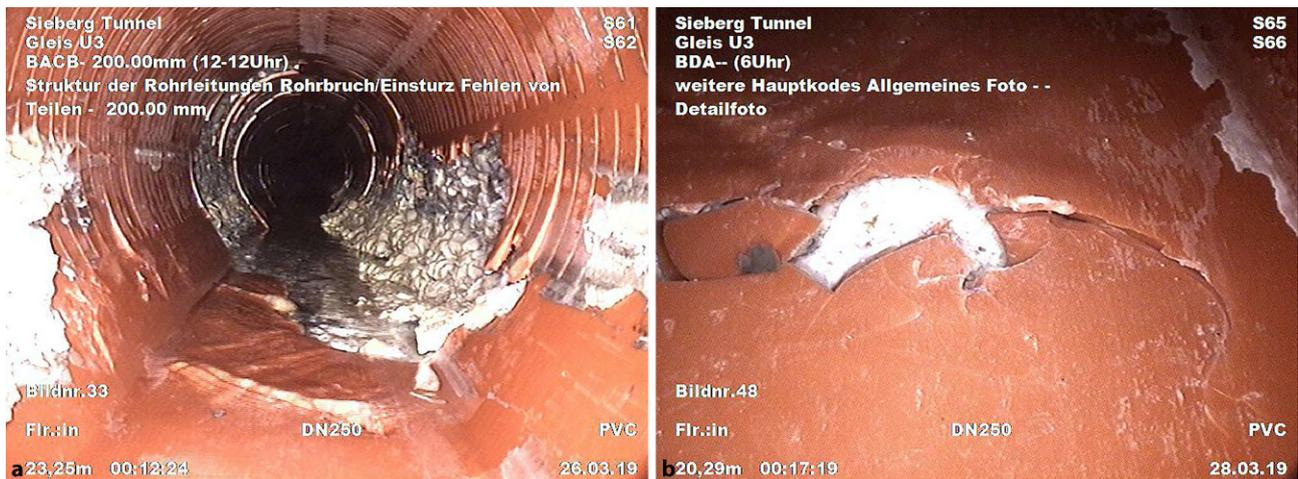
Abb. 2: Kamerabefahrung nach intensiven Reinigungsvorgängen im Tunnel Sieberg – komplette Zerstörung der Rohrwand (a), bzw. lokale Zerstörung der Drainagensohle nach intensiver mechanischer Reinigung (b)
