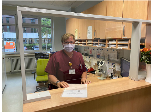
Abb. 3 ◀ Eine neue Schutzwand aus Glas wurde zum Schutz des medizinischen Personals an der Patienten-anmeldung installiert
