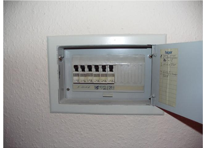
**Abb. 2** ▲ Leitungsschutzschalter der Wohnung, in der sich der versuchte Homizid-Suizid ereignet hat. Ein Fehlerstrom-Schutzschalter ist nicht vorhanden. Bei keinem der Schutzschalter ist es zur Auslösung des Abschaltmechanismus gekommen. Die Nr. 3 bezeichnet den Leitungsschutzschalter für das Schlafzimmer und Bad
