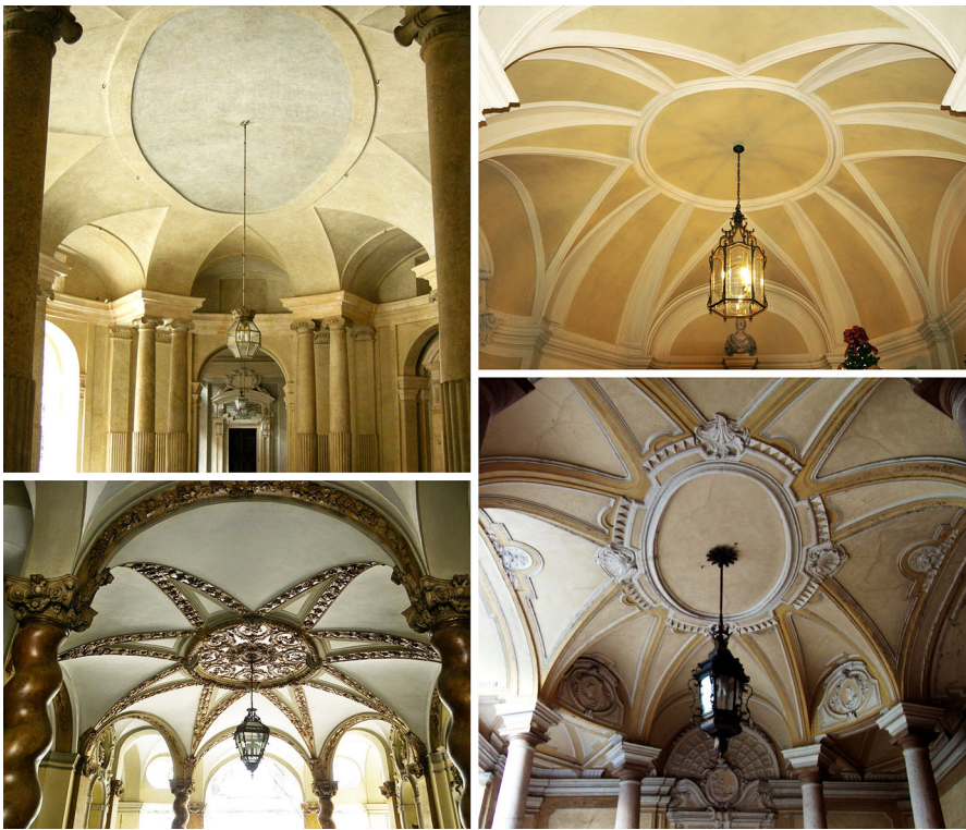
Fig. 1 Star-shaped vaults in the historic city centre of Turin, identified by their addresses: Piazza Carignano 5 (Palazzo Carignano), via Maria Vittoria 4 (Palazzo Asinari di San Marzano), via Santa Teresa 20 (Palazzo Provana di Collegno), Piazza San Carlo 197. Photo: Author
