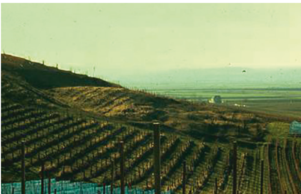
■ Abb. 12.4 Rotationsrutschung bei Ockenheim, Rheinhessen.
