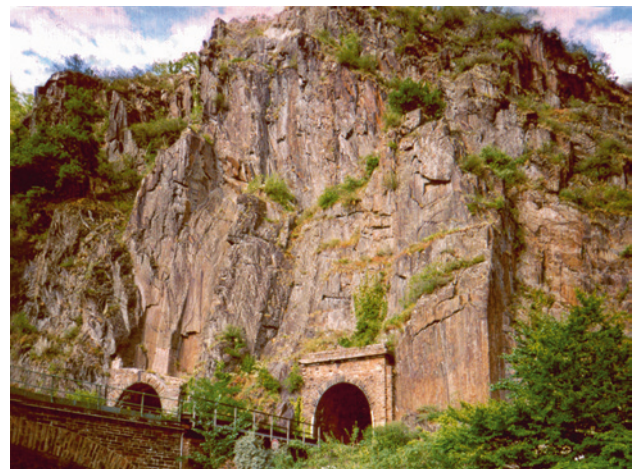
■ Abb. 12.3 Eisenbahntunnel im Ahrtal: Anthropogene Übersteilung einer Felswand durch den Bau von Verkehrsinfrastruktur.
