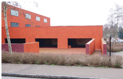
Abb. 15: Hinter Gärten. Eingangsbereich Nordost
