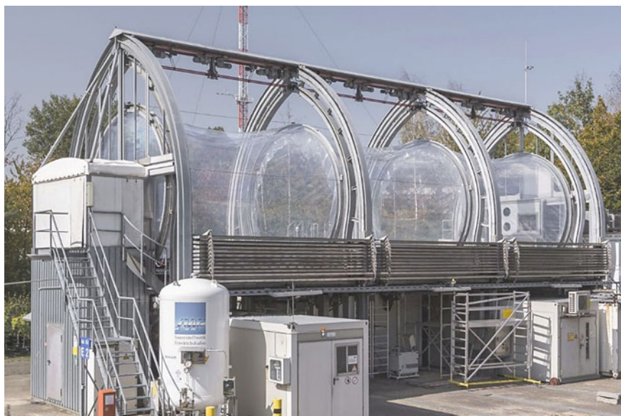
Fig. 1.3 The double wall outdoor chamber SAPHIR in Jülich, Germany (© “Forschungszentrum Jülich/Sascha Kreklau”)
