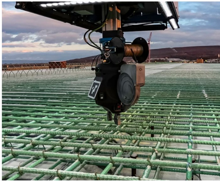
Fig. 12 TyBot rebar tying robot
