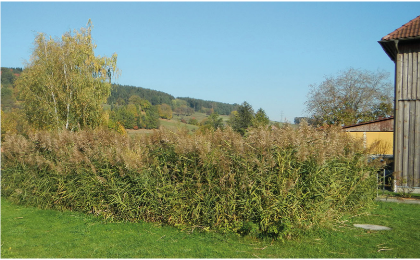
Abb. 1 Vertikal durchströmte Bodenfilter mit intermittierender Beschickung für 9 EW (Fläche: 45 m 2 ). (Foto: Günter Langergraber)
