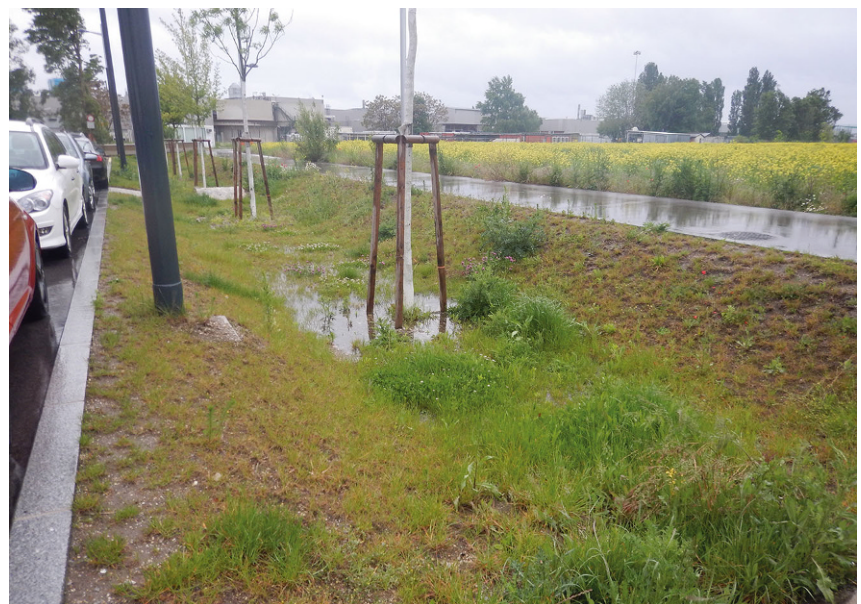
Abb. 2 Anlage zur Regenwasserversickerung sowie Wasserversorgung von Bäumen. (Foto: Alexander Pressl)
